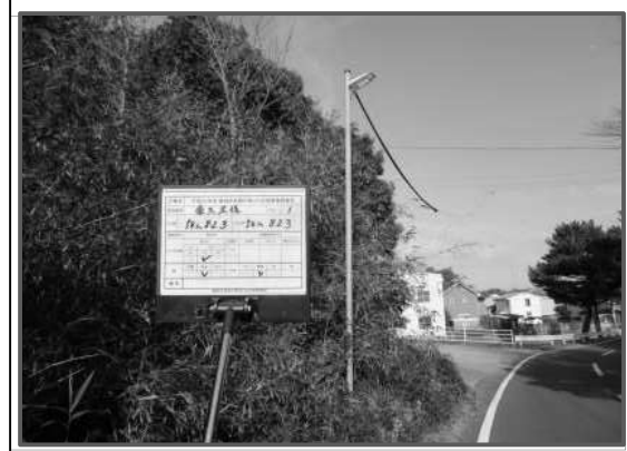
作業完成全景写真
