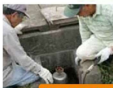
給水栓の点検
