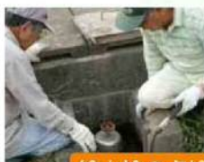
給水栓の点検
