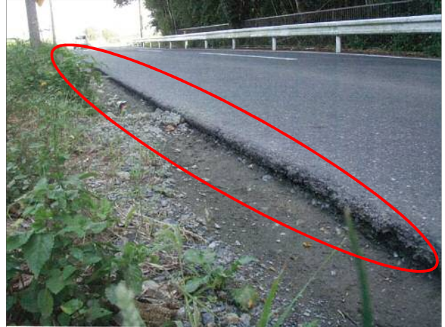
② 路肩が欠落し危険である。
