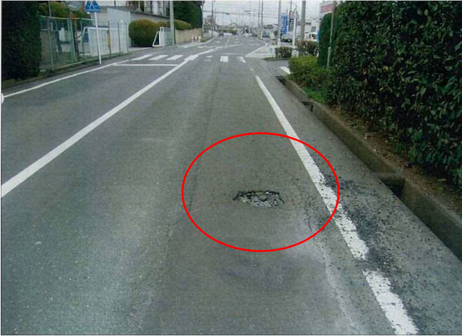
① 舗装に穴があいている。
