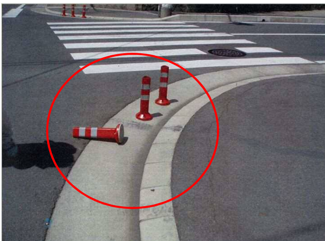
③ 安全施設等が破損している。
