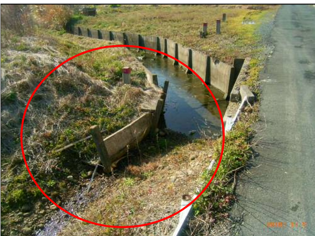
⑤ 排水路が破損している。
