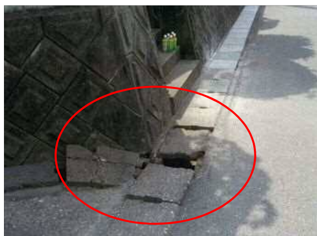
④ 側溝の本体や蓋板が破損している。
