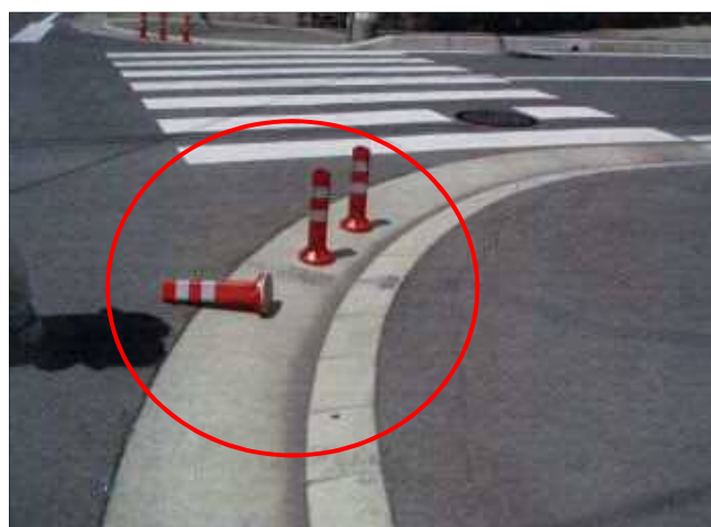
③ 安全施設等が破損している。
