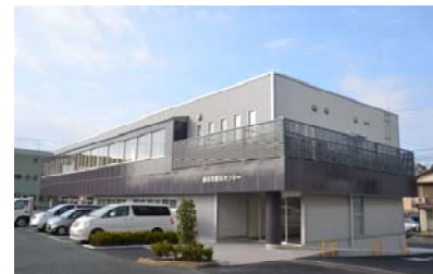
防災センター
