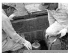
給水栓の点検
